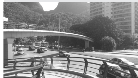
Passarela sobre a Autoestrada Lagoa-Barra
