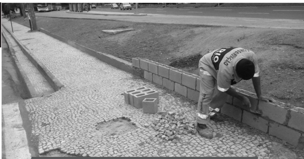
Funcionário da Conservação colocando barreira necessária
