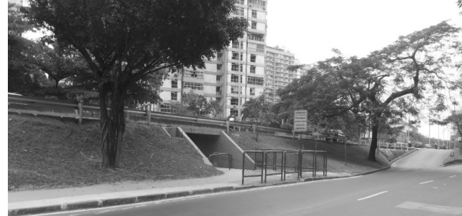
Passagem subterrânea sob a Autoestrada Lagoa Barra
