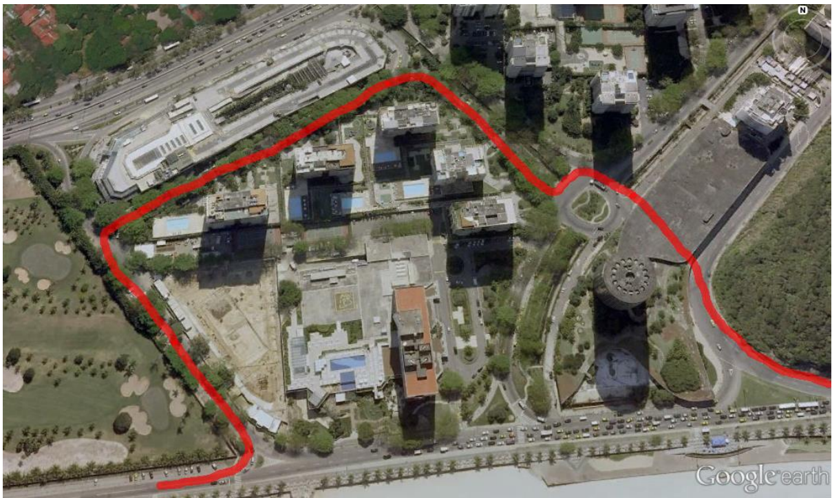
FOTO 2 - Situação anterior ao fechamento da passagem sob o Hotel Nacional (Área 1)
