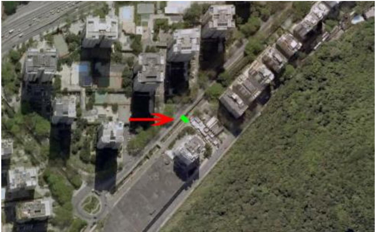
FOTO 3 - Platô a ser instalado sobre o canal da Av. Aquarela do Brasil
